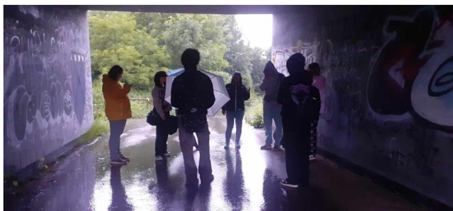
Pod mostem kolejowym, ul. Elektrowniana
