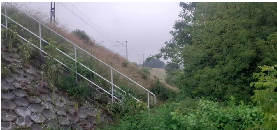
Teren przy nasypie kolejowym, ul. Elektrowniana
